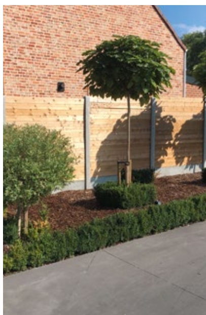
Clôture massive en pin avec poteaux et plaques en béton
