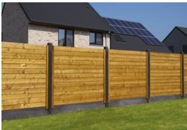
Clôture massive résineux avec poteaux et plaques en béton anthracite
