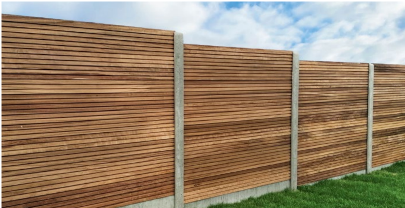
Clôture massive en thermo ayous
