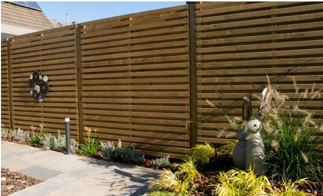
Placé avec des poteaux en bois
