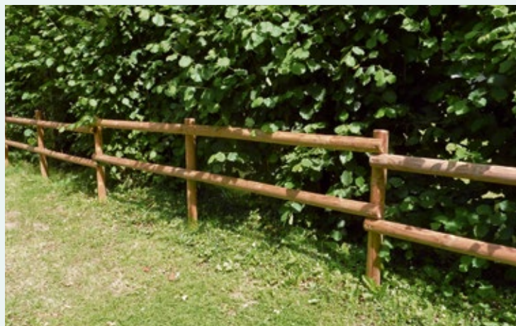
Une clôture avantageuse en rondins avec des traverses en demi-rondins, fixées avec des tire-fond
