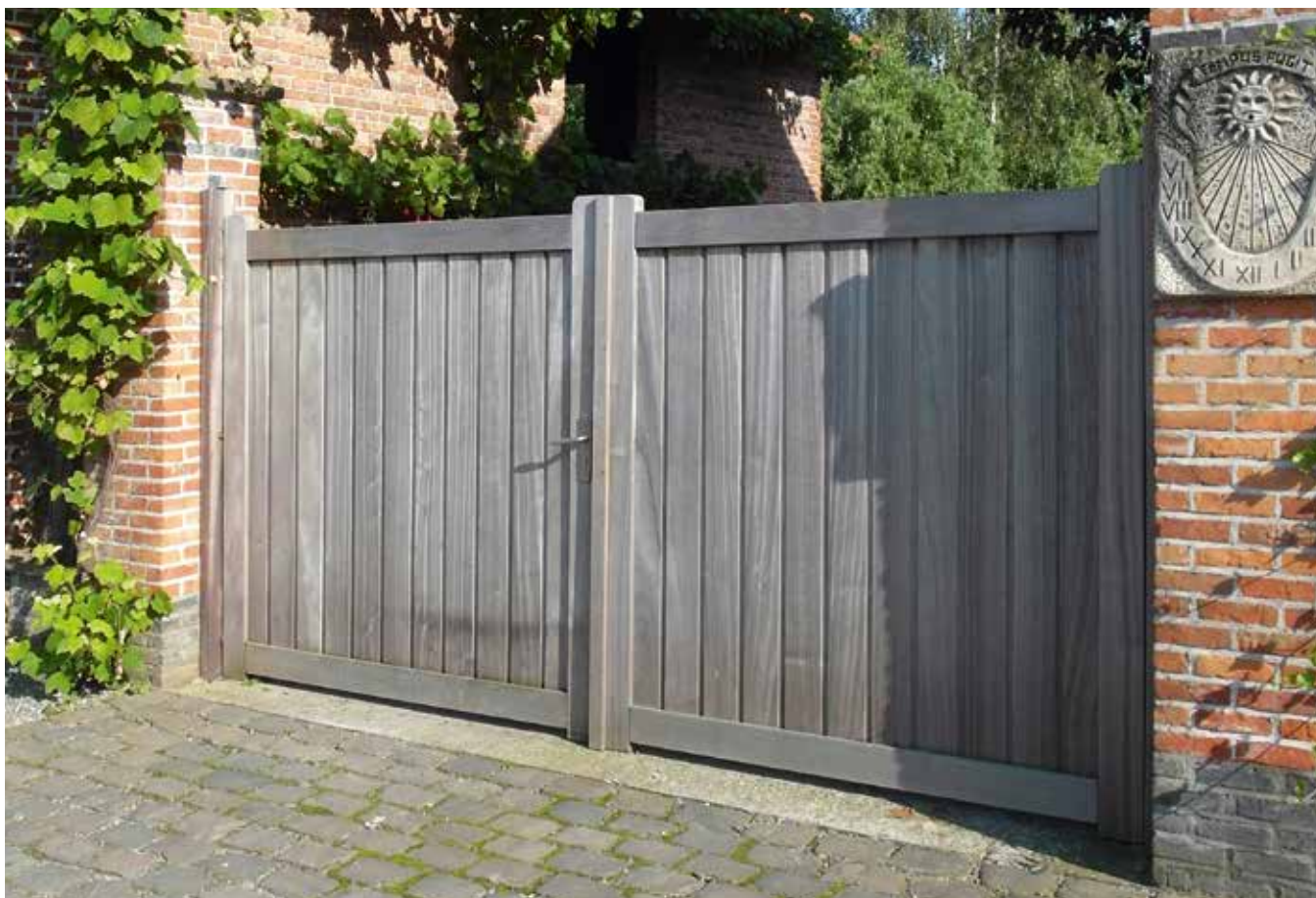
180 x 300 cm padouck; ici planches à tenon et mortaise
